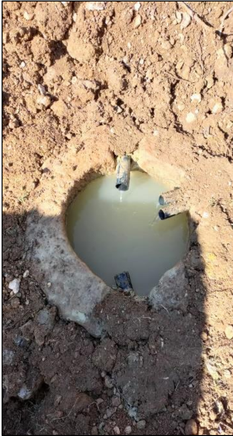
1000 m İçme Suyu İsale Hattı Yapım İşi
