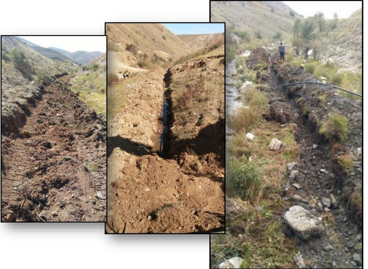
Balca Köyü 900 m İçme Suyu İsale Hattı
