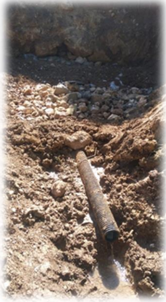
Buğdaylı Köyü İçme Suyu Drenaj Çalışması
